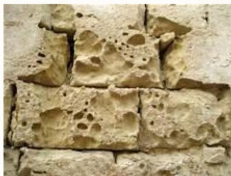
Fig 3- Parede corroida pelas chuvas ácidas
